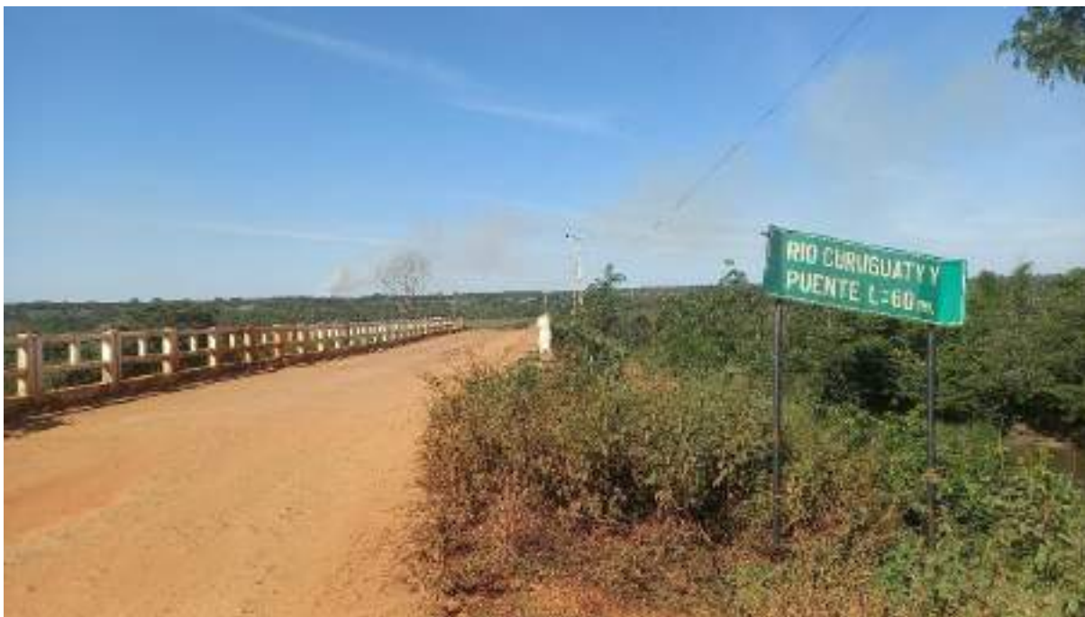
Fotografía N° 18: Esta previsto ensanchar el Puente sobre el Rio Curuguay y
