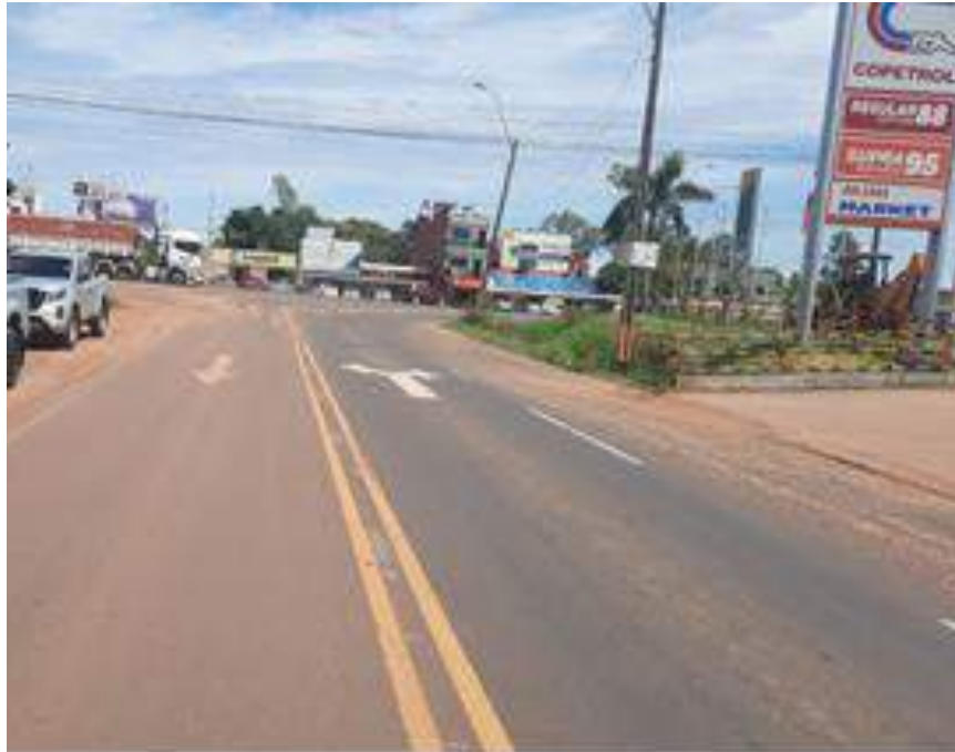
Fotografía N° 2: Fin del tramo en la zona urbana de Yby Yajú
