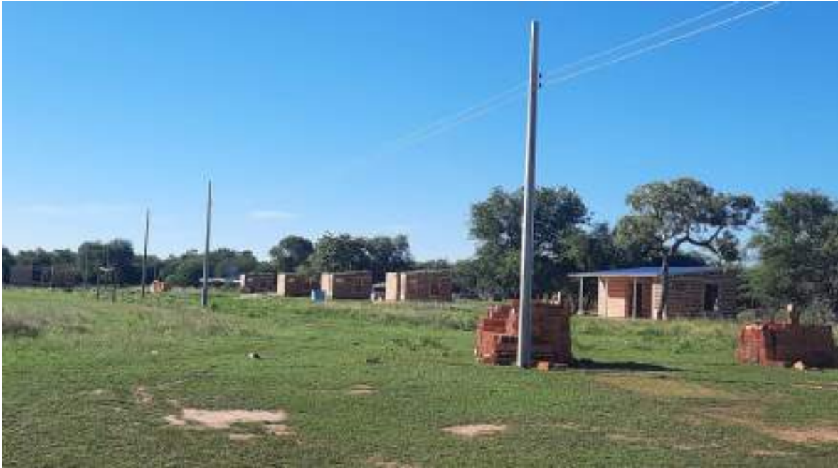
Fotografía N° 5: Vista de calle principal y viviendas en construcción.
