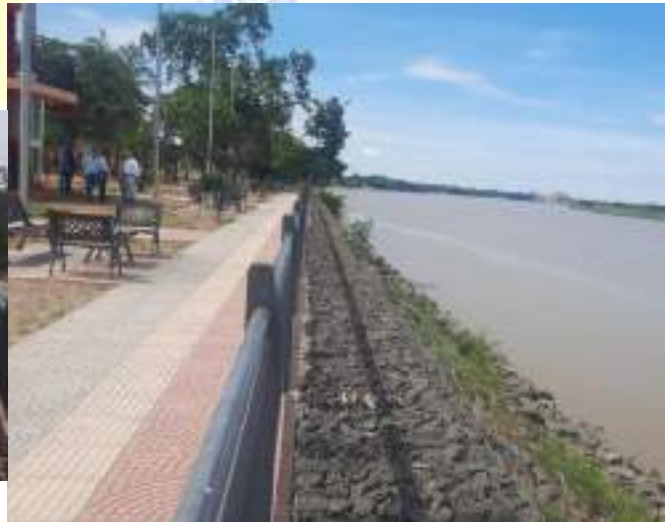
Fotografía N° 7: Obras en el mirador: enrocado y colocación del sistema de gaviones
