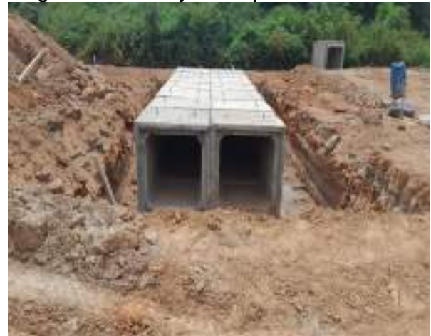
Fotografía N° 6: Obras de alcantarilla tubular doble
