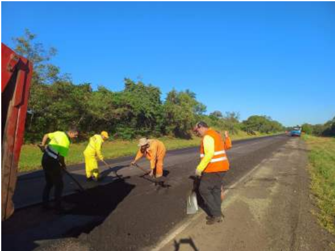
Fotografía N° 16: Trabajo de bacheo en ejecución en la compañía de Añaretangue llegando al desvío a San José Obrero.
