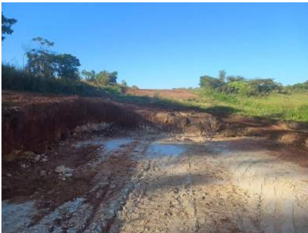
Fotografía N° 10: Fin del recorrido con trabajos de movimiento de suelo.
