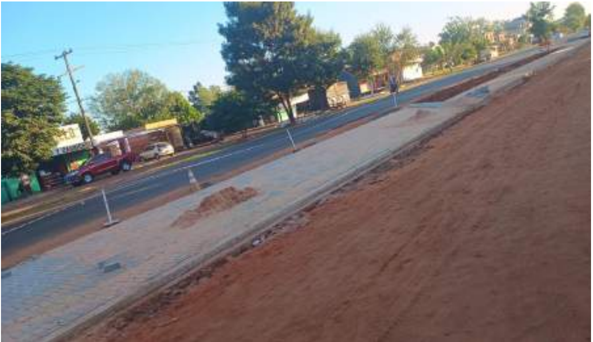
Fotografía N° 5: Obras de seguridad vial en ejecución, frente a la Estación de Servicio Puma en la ciudad de Capiibary, sobre la Ruta D006.
