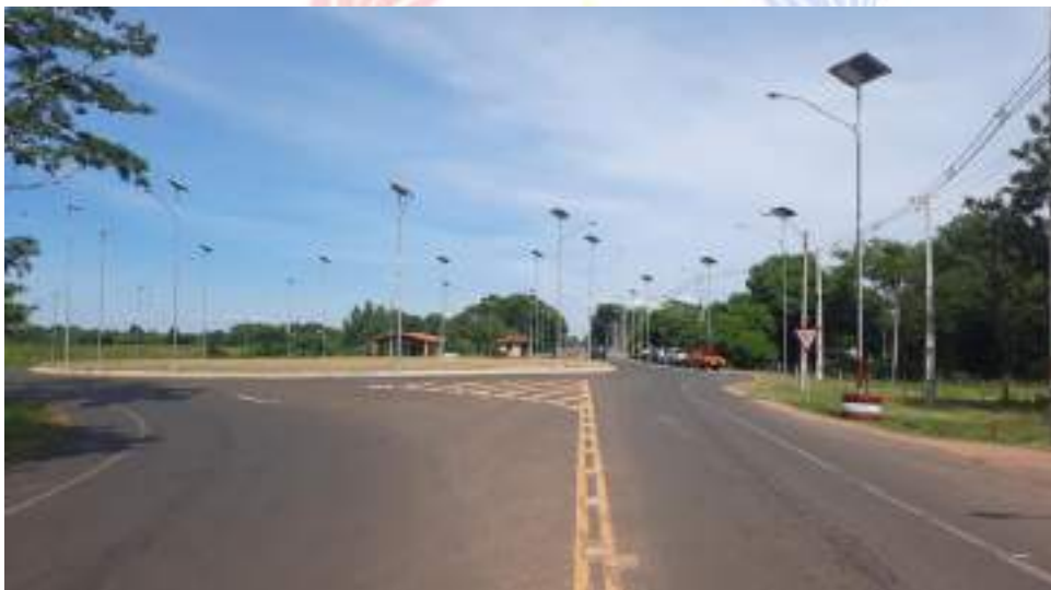
Fotografía N° 1: Rotonda de acceso al Puerto de Antequera y al núcleo urbano de Antequera, construido
