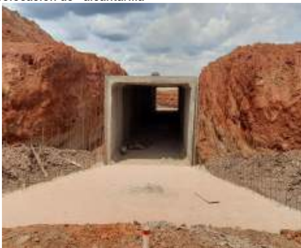
Fotografía N° 13: Tramo del Lote 2 en construcción con alcantarilla
