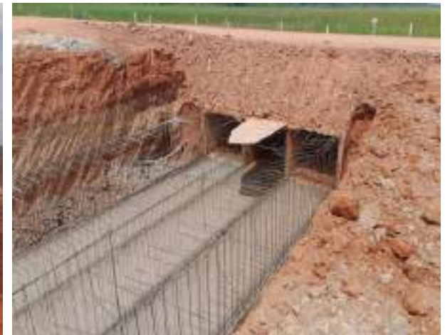
Fotografía N° 12: Fabricación in situ de alcantarilla
