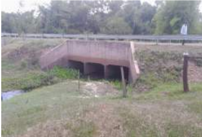
Fotografía N° 7: Obra de alcantarilla con trabajos de mantenimiento y limpieza
