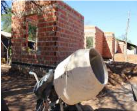
Fotografía N° 5: Viviendas en construcción.
