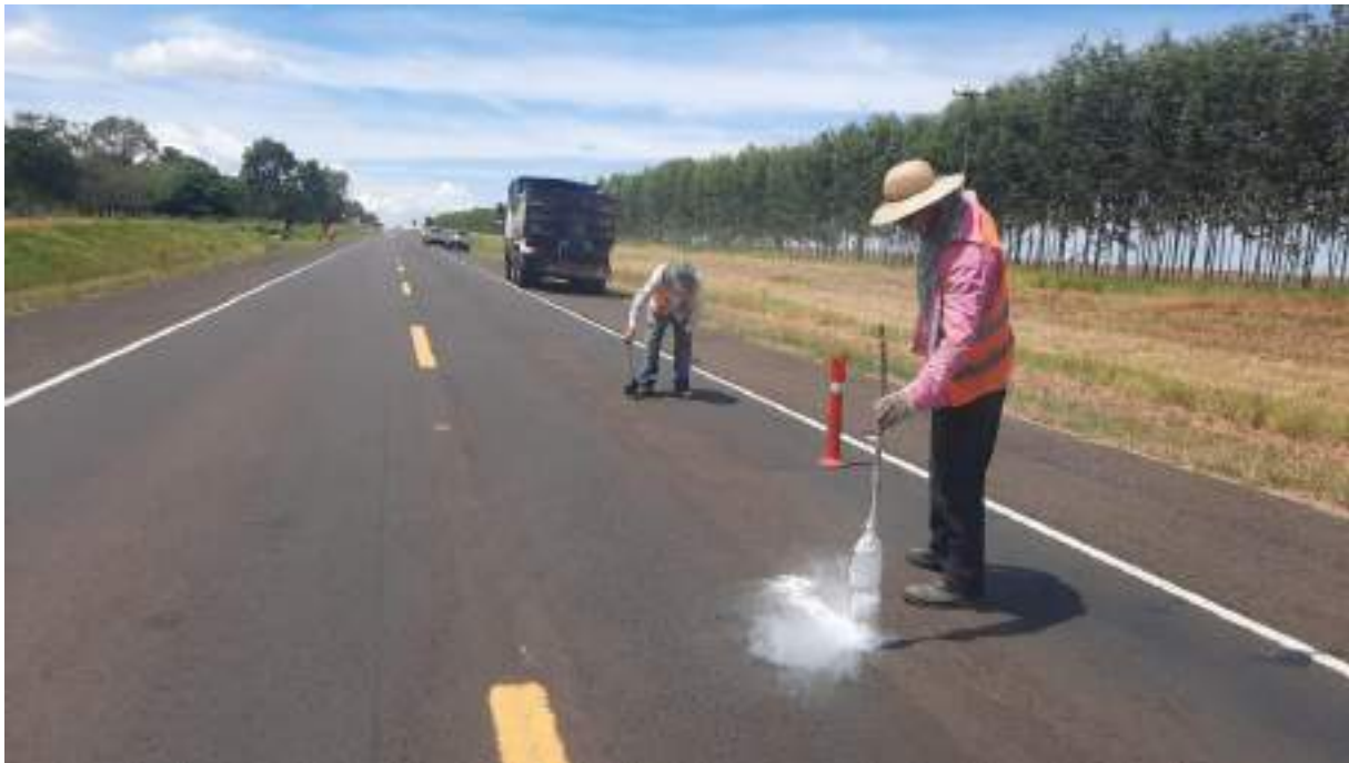
Fotografía N° 3: Reposición de pinturas de las señalizaciones horizontales.
