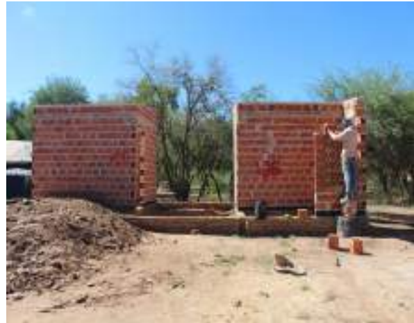
Fotografía N° 6: Vivienda en construcción.
