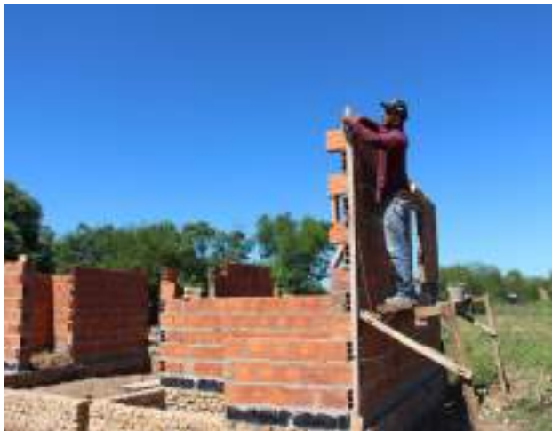
Fotografía N° 4: Vivienda en construcción.
