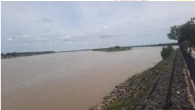
Fotografía N° 6: Obras en el mirador: enrocado y colocación del sistema de gaviones
