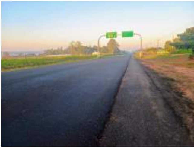
Fotografía N° 2: Ruta pavimentada, pero sin las señalizaciones horizontales a inicio del tramo.
