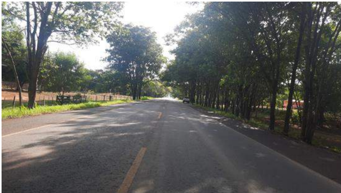
Fotografía N° 3: Estado de la ruta. Área próxima a la localidad de Horqueta.
