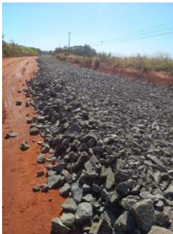
Fotografía N° 4: Sub base de macadam en una calzada del tramo intervenido.
