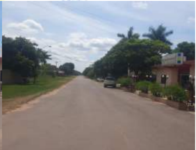
Fotografía N° 4: Pavimentación asfáltica sobre empedrado en ruta calle principal de Antequera
