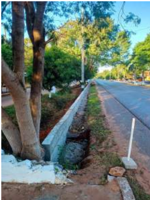
Fotografía N° 10: Construcción de obras de seguridad vial sobre la Ruta D006.
