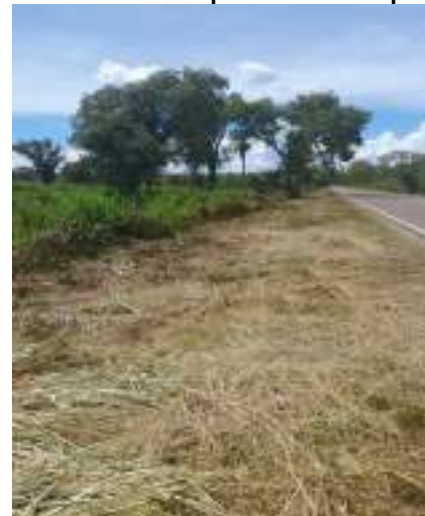
Fotografía N° 6: Trabajos de mantenimiento de franja de dominio
