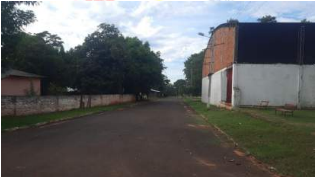
Fotografía N° 5: Regularización asfáltica sobre empedrado en calles del municipio de Nueva Germania (Vista de calle adyacente al Polideportivo Municipal).
