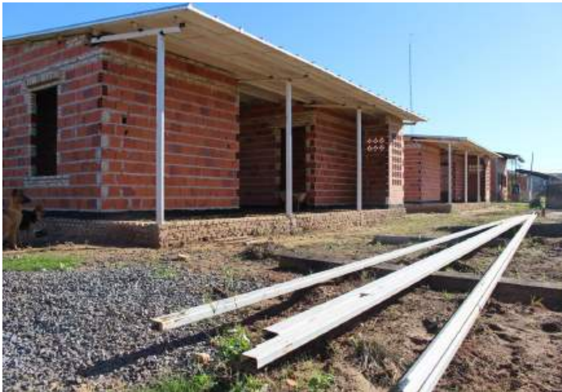
Fotografía N° 4: Viviendas en construcción, techadas.
