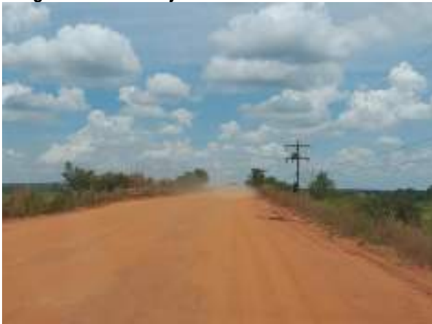
Fotografía N° 5: Vista del estado actual en otro tramo
