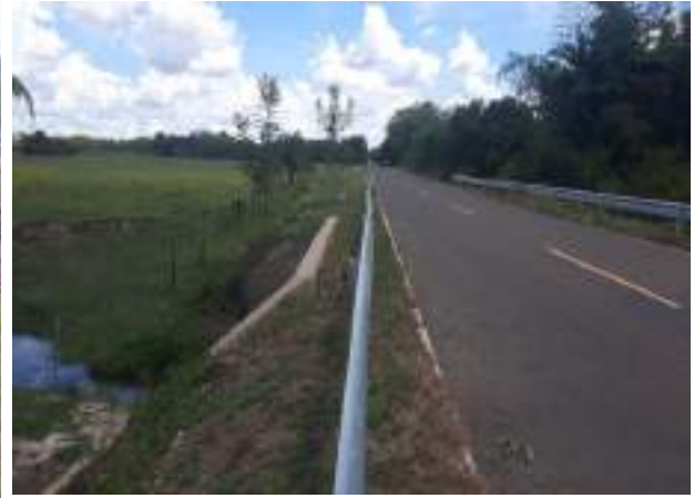
Fotografía N° 8: Vista de altura de terraplén
