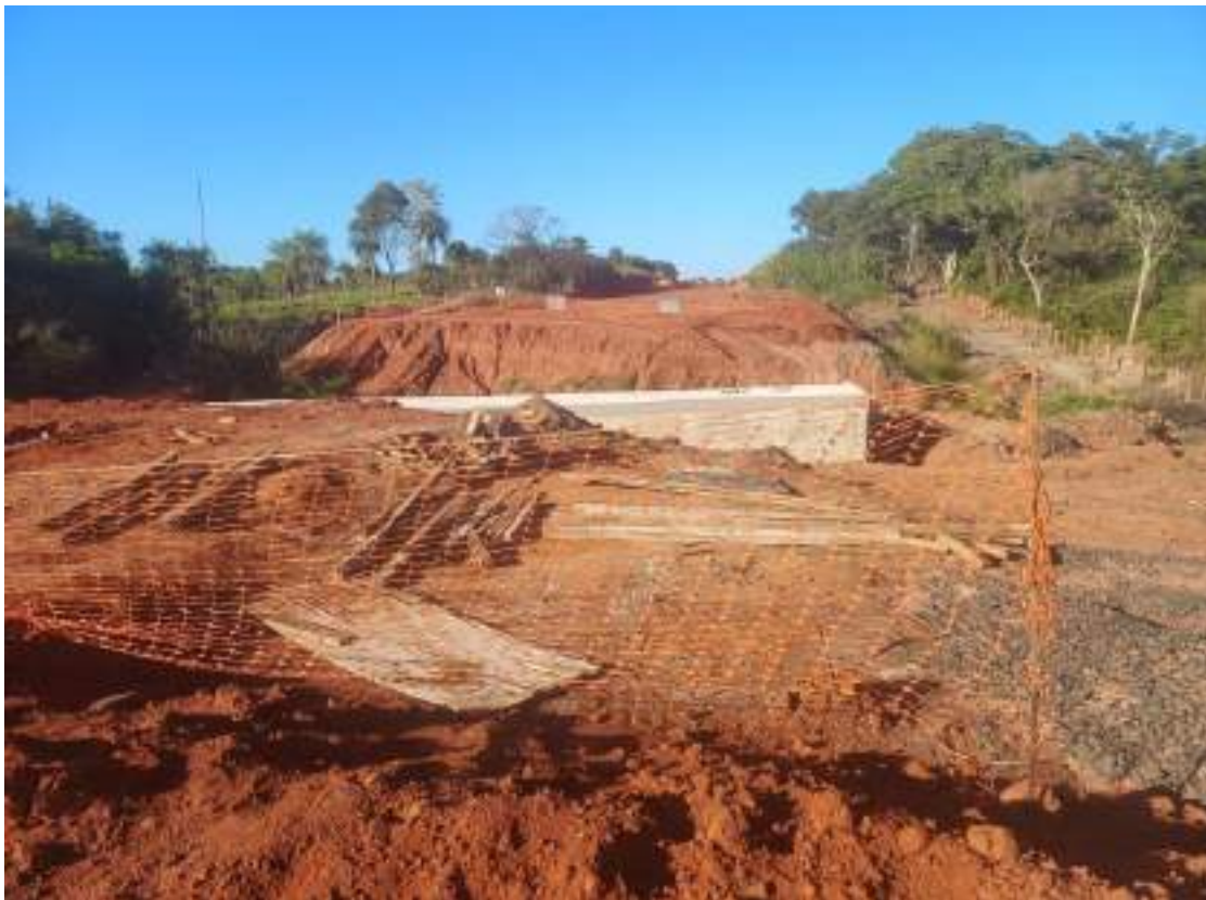
Fotografía N° 6: Construcción de alcantarillas de hormigón armado.
