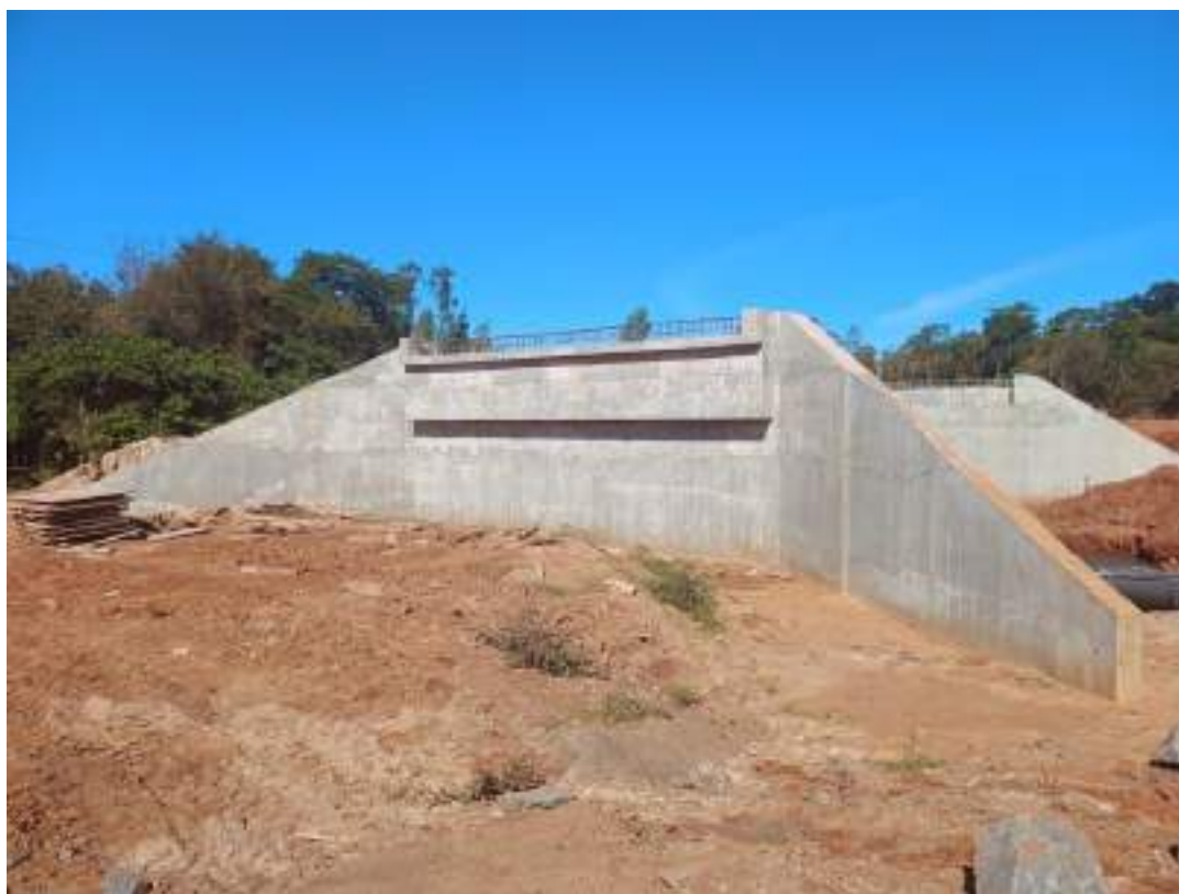
Fotografía N° 15: Estado actual del puente de H°A° en construcción sobre el Arroyo Barranquera Limpio
