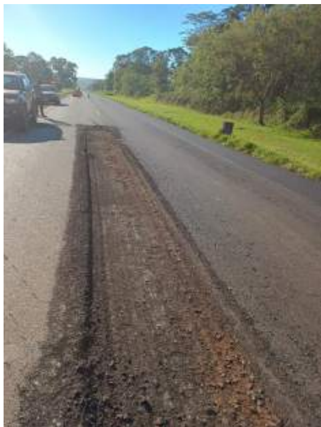
Fotografía N° 18: Trabajo de bacheo superficial en ejecución
