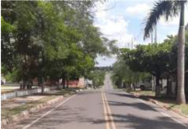
Fotografía N° 1: Inicio del tramo monitoreado Progresiva 15+100
