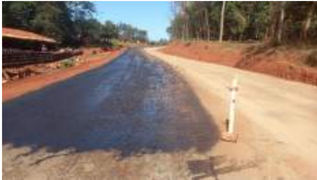
Fotografía N° 6: Colocación de la base imprimada.
