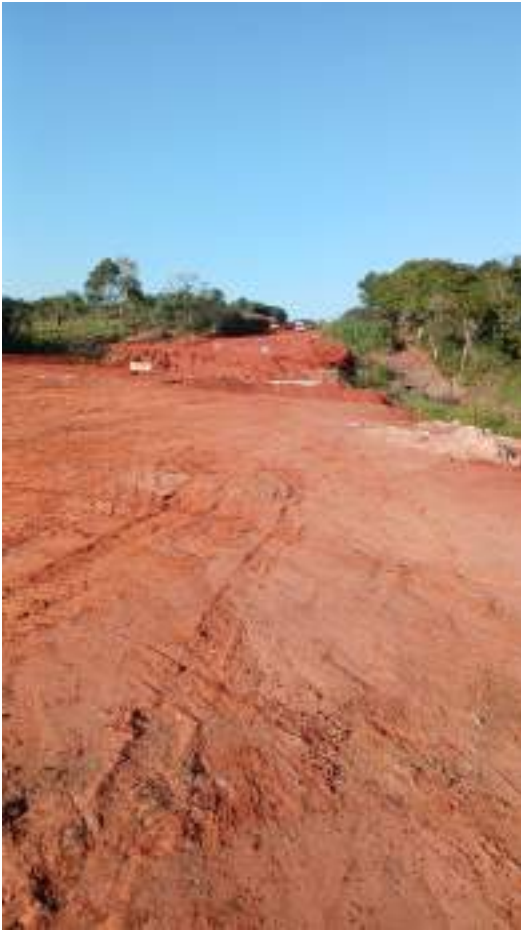
Fotografía N° 2: En proceso de terraplenado.
