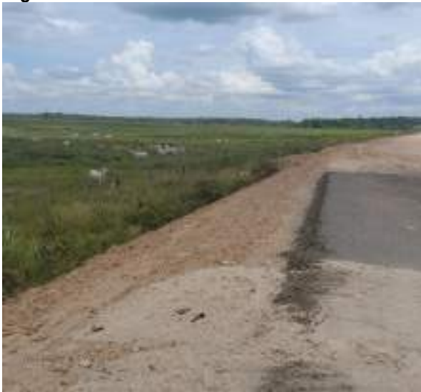
Fotografía N° 7: Vista de terraplén en zona de esteral Jacare Ñe'e
