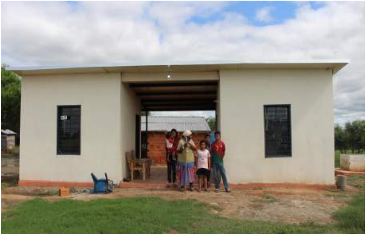
Fotografía N° 6: Vivienda concluida. Familia beneficiaria.
