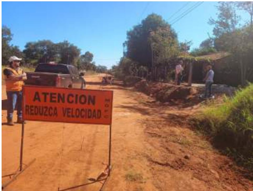
Fotografía N° 2: Reposición de linderos por obreros de la contratista, que en su mayoría son de la zona de obra.
