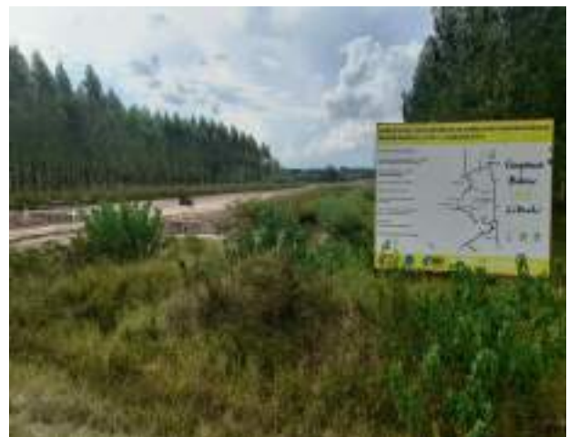
Fotografía N° 20: Inicio del Lote 1 del proyecto y fin del recorrido
