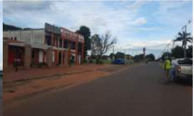
Fotografía N° 2: Regularización asfáltica sobre empedrado frente a la Municipalidad de Santa Rosa del Aguaray.
