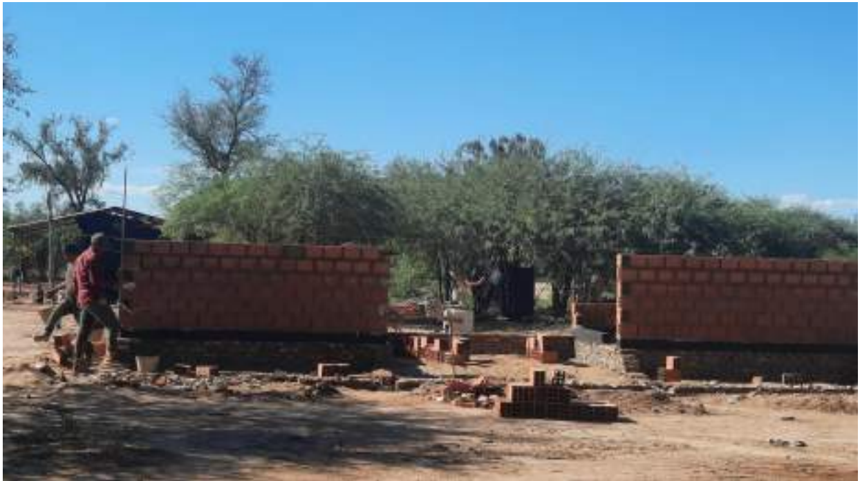
Fotografía N° 4: Vivienda en construcción al nivel de las aberturas.
