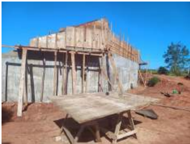
Fotografía N° 13: Obras de hormigonado sobre el Arroyo La Familia
