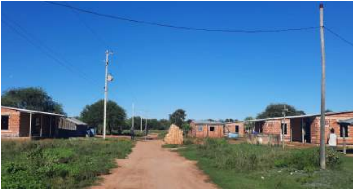
Fotografía N° 3: Vista de calle principal y viviendas en construcción.
