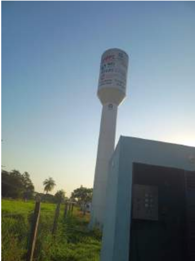
Fotografía N° 13: Pozo de altura
