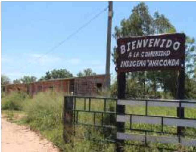
Fotografía N° 1: Área de acceso a la comunidad y viviendas en construcción.
