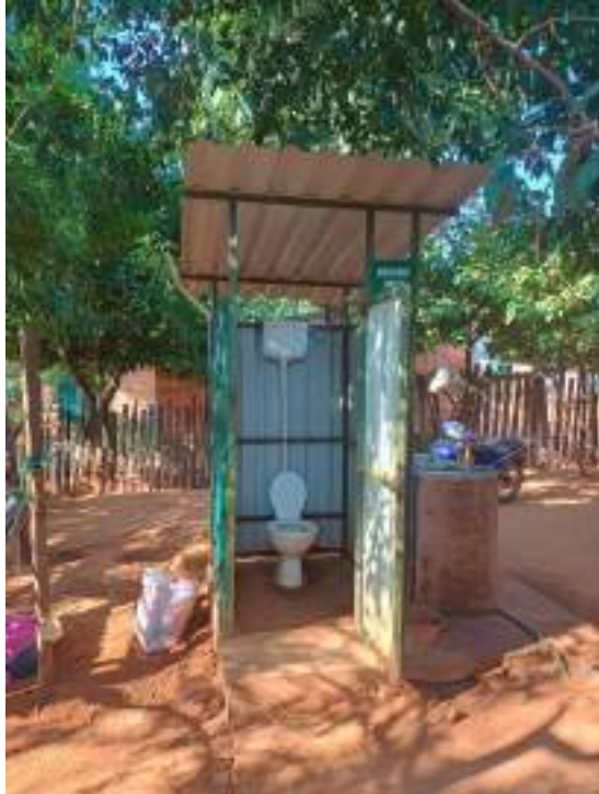
Fotografía N° 3: El Baño cuenta con inodoro, cisterna alta y ducha
