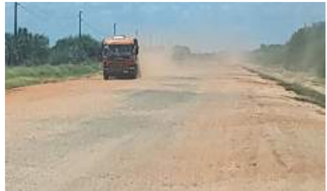
Fotografía 2: Estado actual de parte del tramo.
