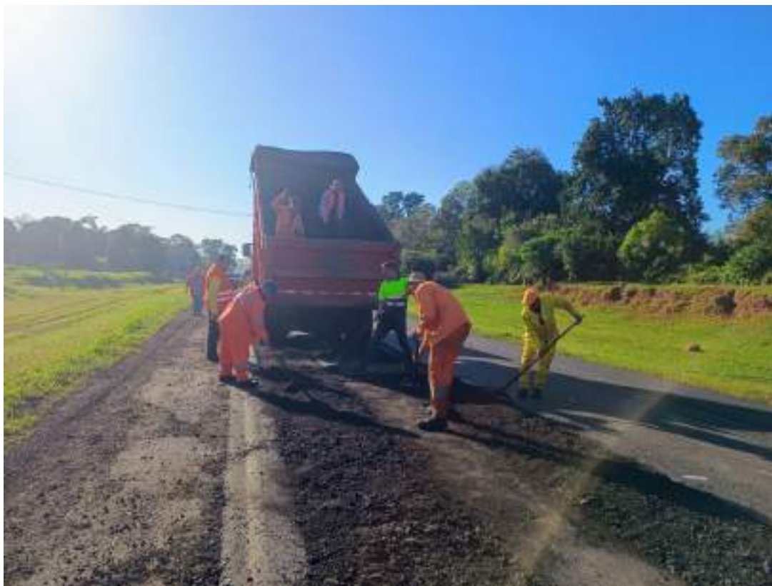
Fotografía N° 17: Trabajo de bacheo hasta Santa Rosa del Mbutuy en diferentes tramos.
