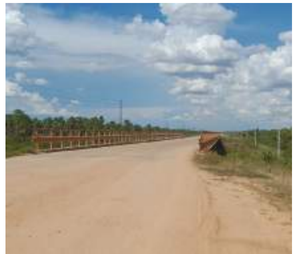
Fotografía 2: Acceso a puente
