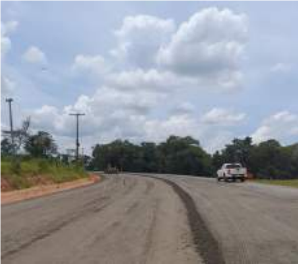
Fotografía N° 3: Trabajos de bases de suelo en un tramo
