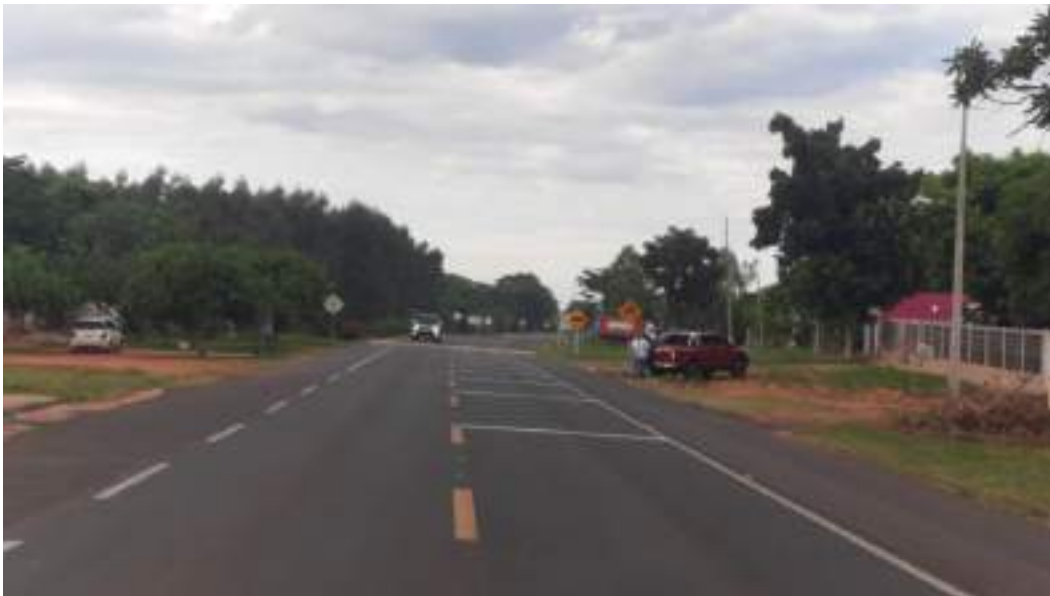
Fotografía N° 3: Señalización vertical y horizontal instalada de la Ruta Nacional N° 11 en Santa Rosa del Aguaray.
