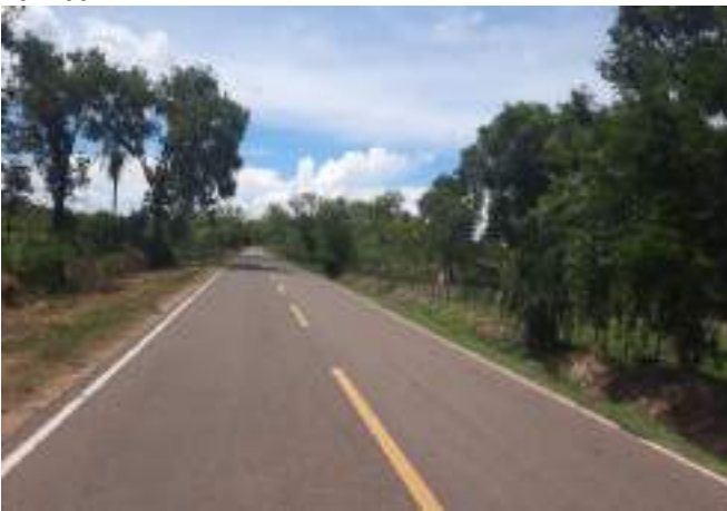
Fotografía N° 3: Estado actual de un tramo del proyecto
