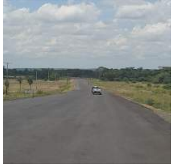
Fotografía N° 4: Trabajos de capas asfálticas
