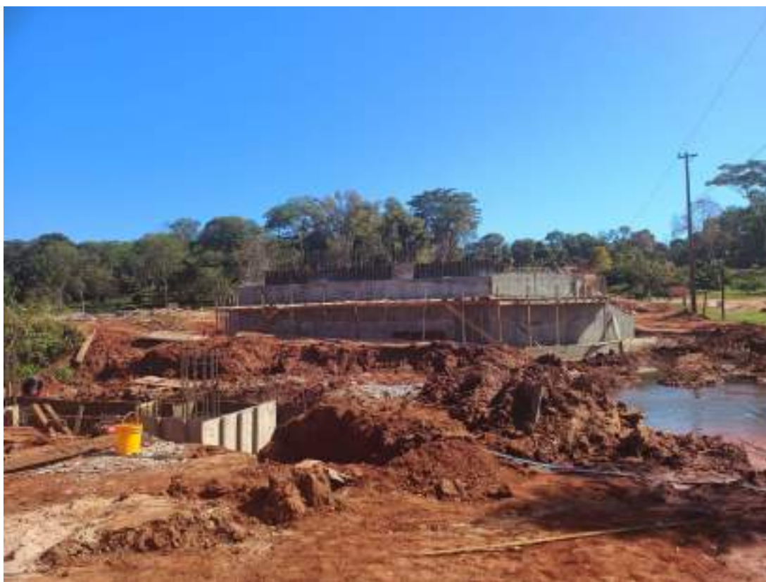
Fotografía N° 12: Vista actual de la construcción del puente sobre el Arroyo La Familia
