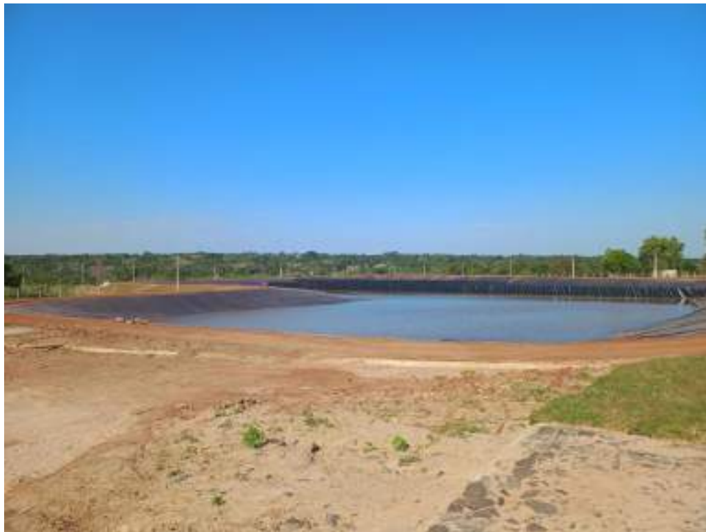
Fotografía N° 5: Laguna donde se trata el agua proveniente de los hogares y comercios
