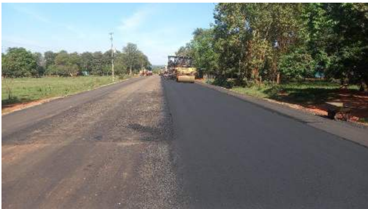
Fotografía N° 10: Colocación del asfalto en un lado de la calzada.
