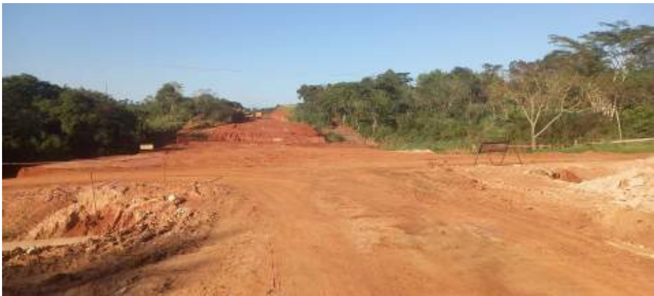
Fotografía N° 1: Estado actual de la obra de circunvalación.
