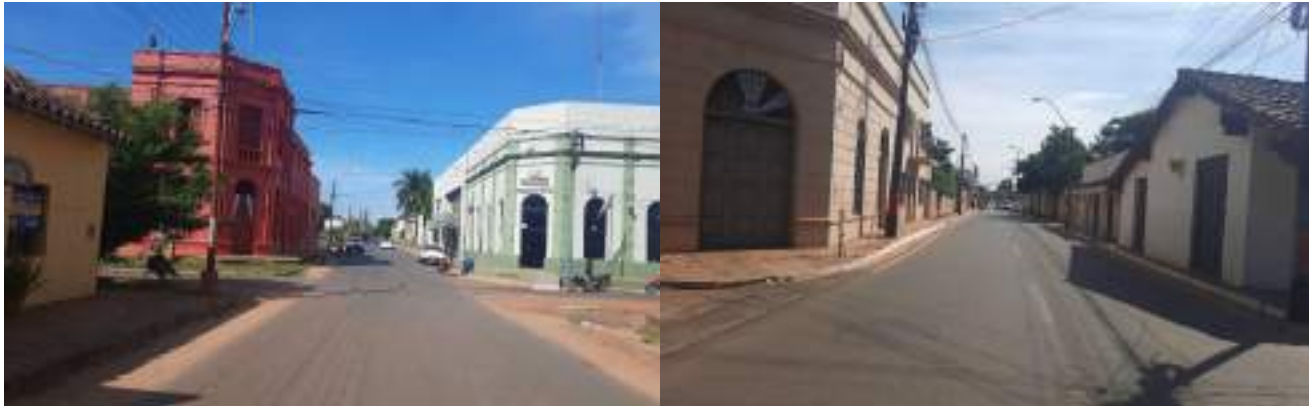
Fotografía N° 12: Calle con reconstrucción de concreto asfáltico.
