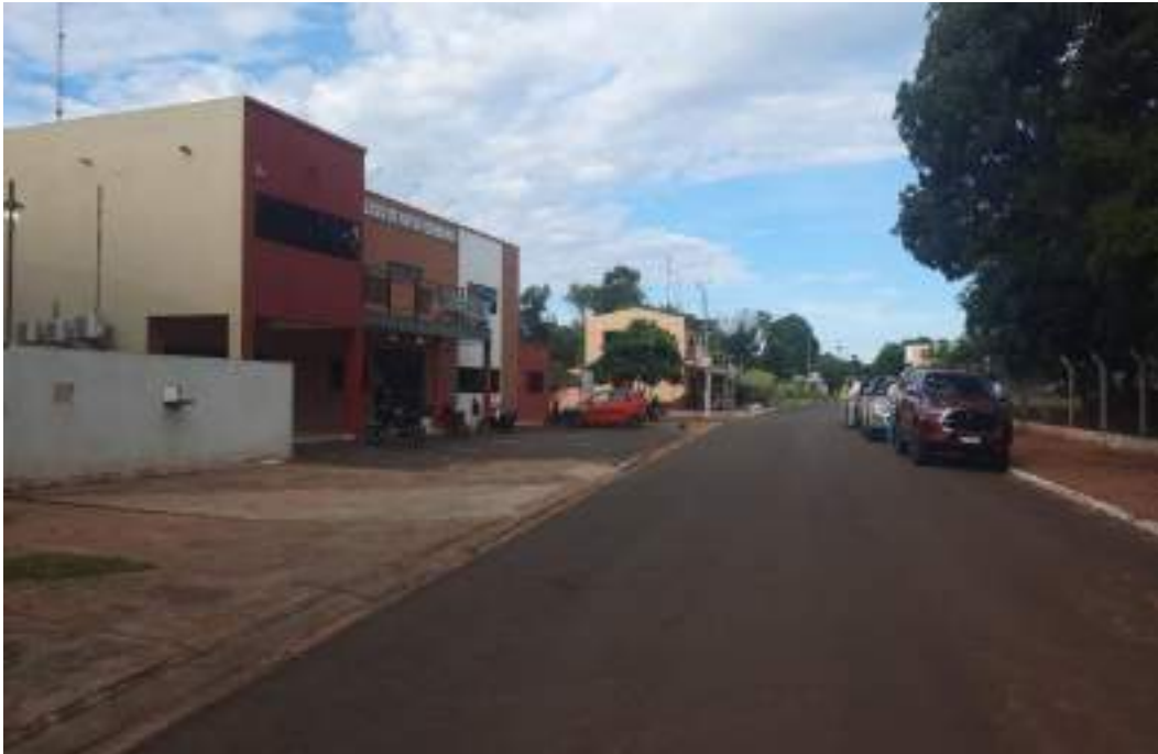
Fotografía N° 4: Regularización asfáltica sobre empedrado frente a la Municipalidad de Nueva Germania
