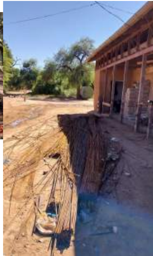
Fotografía N° 8: Stock de materiales de construcción.
