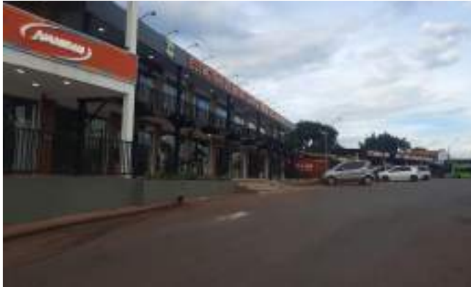
Fotografía N° 1: Regularización asfáltica sobre empedrado frente a la Terminal de Ómnibus de Santa Rosa del Aguaray.
