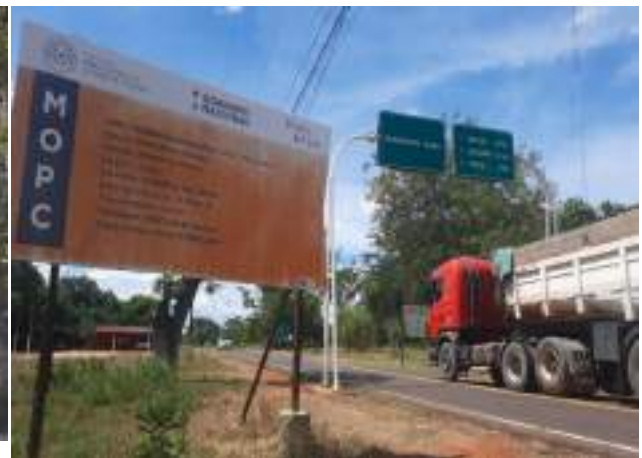
Fotografía N° 10: Cartel de la obra en el inicio del tramo con tránsito de vehículos de gran porte el cual está prohibido.
