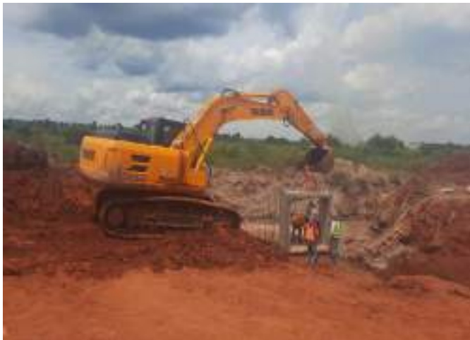
Fotografía N° 11: Trabajos de excavación para colocación de alcantarilla
