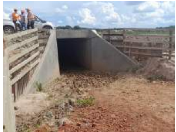
Fotografía N° 16: Túnel para cruce de ganado lote 1
