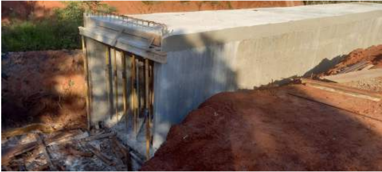
Fotografía N° 7: Construcción de alcantarillas celular de hormigón armado de 2x2.
