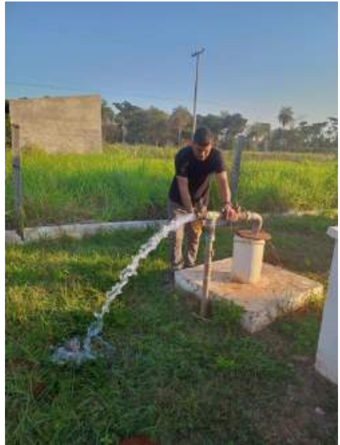
Fotografía N° 14: Comprobando la potencia del agua
