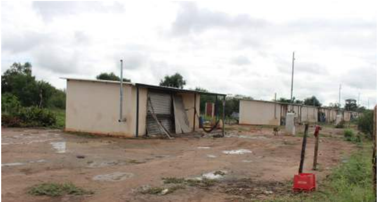
Fotografía N° 2: Vista frontal lateral de viviendas construidas.
