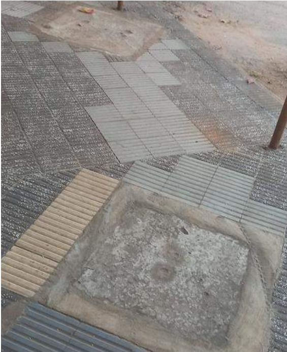
Fotografía N° 13: Redes Condominiales (por manzana)
