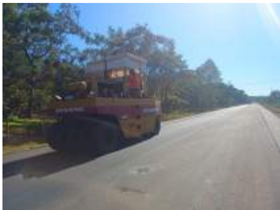
Fotografía N° 8: Colocación de capa asfáltica en ambas calzadas.
