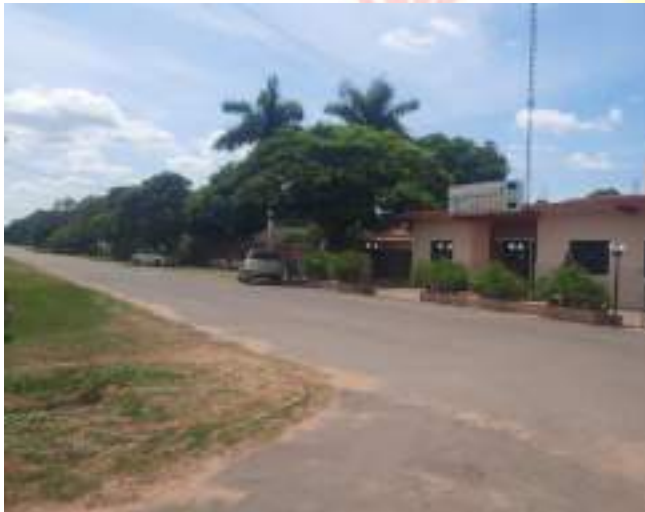
Fotografía N° 3: Pavimentación asfáltica sobre empedrado en ruta calle principal de Antequera
