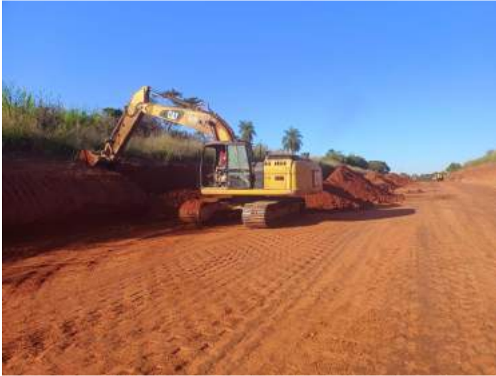
Fotografía N° 5: Excavación para obras de artes.
