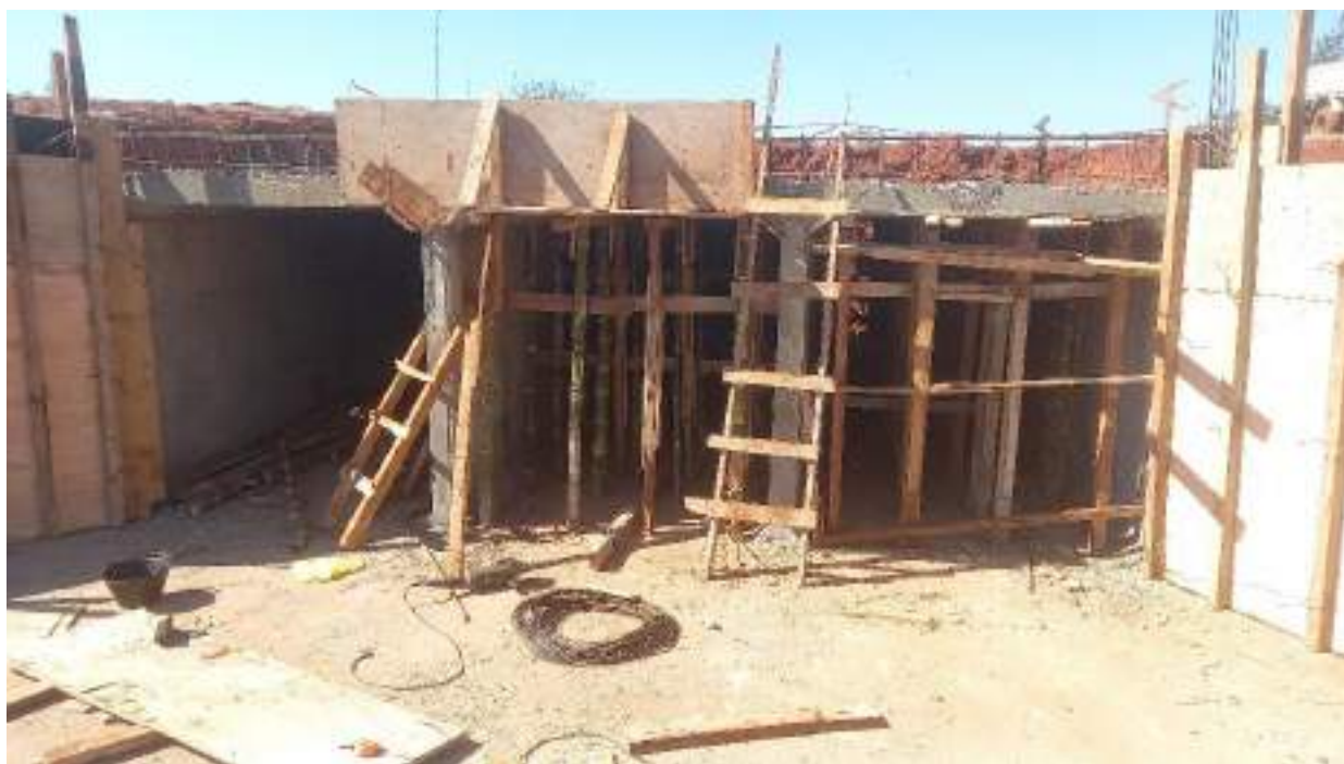
Fotografía N° 17: Aliviadero triple de 2 x 2 mts.
