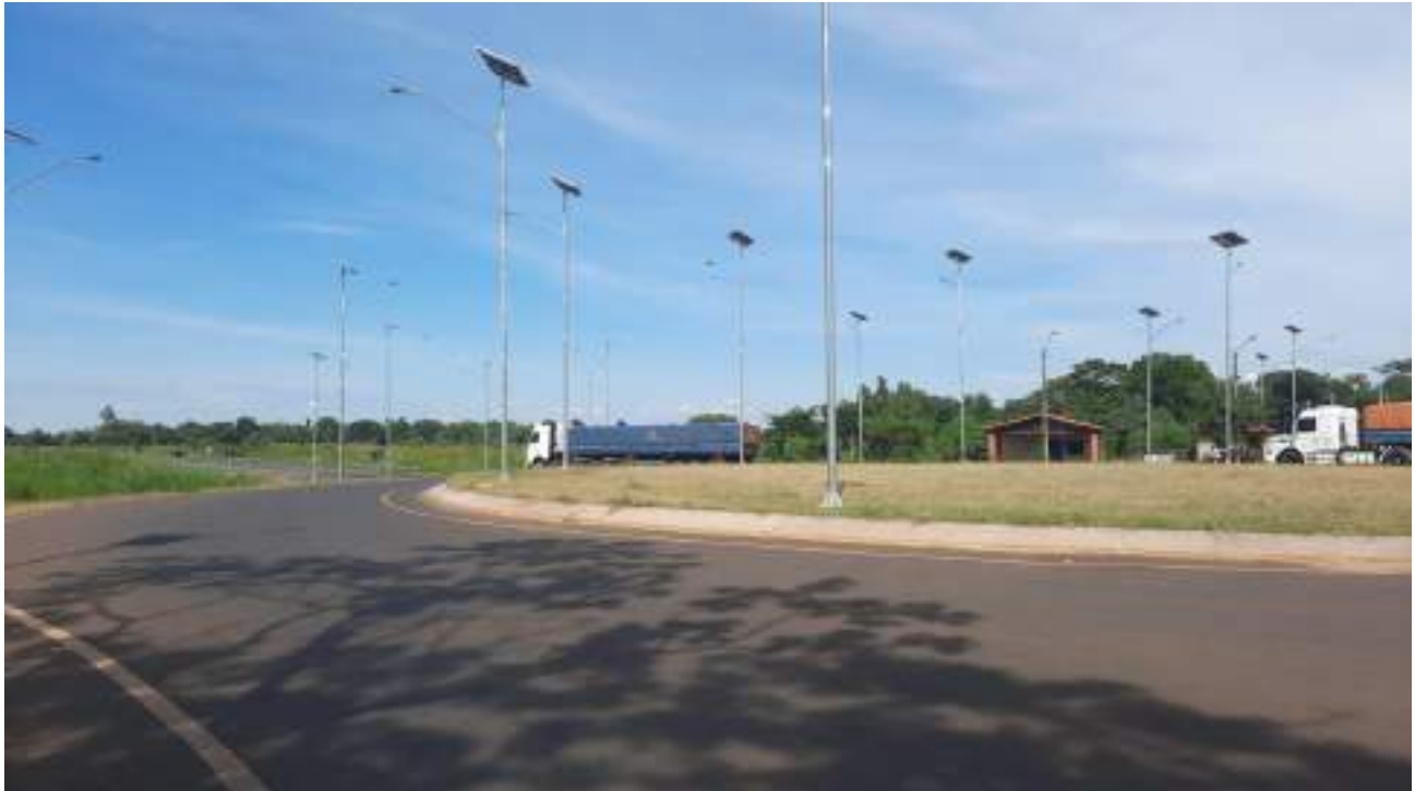
Fotografía N° 2: Rotonda en el acceso a Antequera
