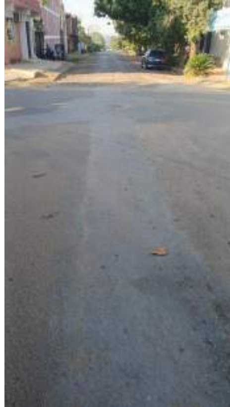
Fotografía N° 14: Redes básicas (a lo largo de la calle)
