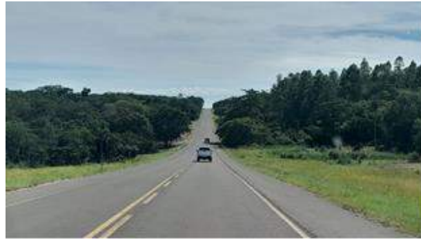
Fotografía N° 5: Vista frontal del tramo de la Ruta N° 5 en óptimas condiciones.
