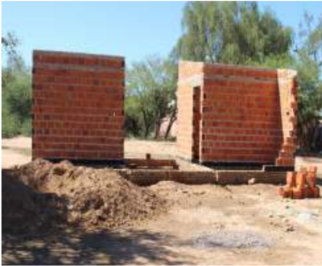
Fotografía N° 2: Vivienda en construcción al nivel de la altura.
