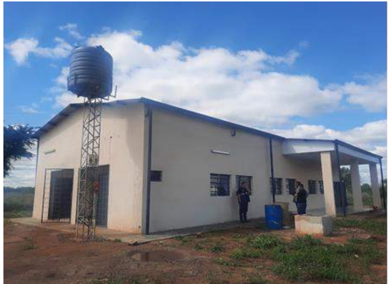
Fotografía N° 4: Vista frontal lateral del Centro Comunitario finalizado.
