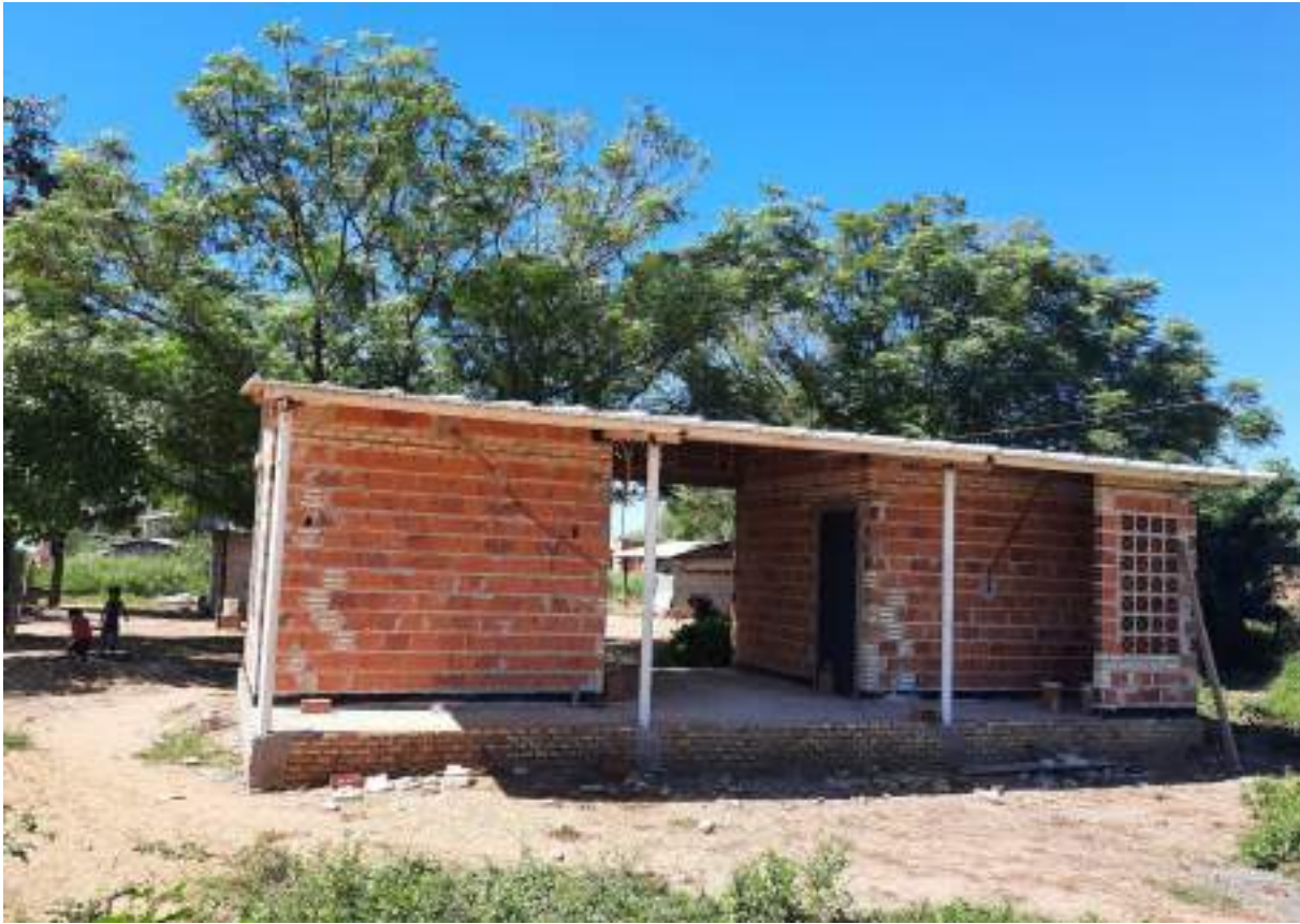
Fotografía N° 6: Vivienda en construcción, techada.
