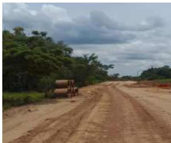
Fotografía N° 2: Camino de tierra en parte del lote 3
