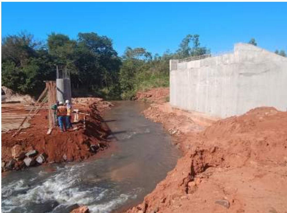
Fotografía N° 16: En proceso de ejecución de las obras sobre el Arroyo Barranquera Limpio
