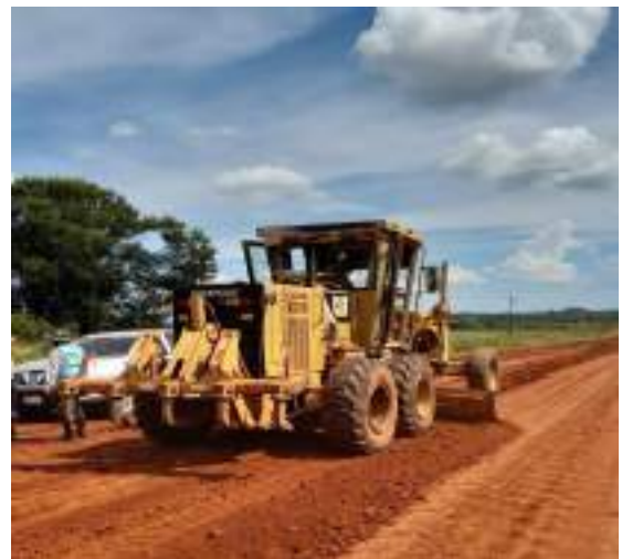
Fotografía N° 14: Trabajos de Movimiento de Suelo lote 2
