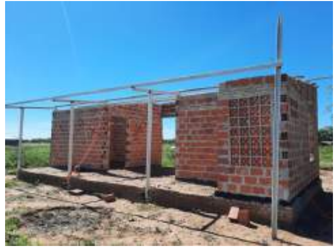
Fotografía N° 5: Vivienda en construcción.
