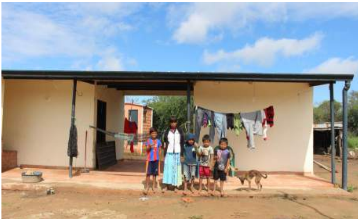
Fotografía N° 6: Vivienda concluida. Familia beneficiaria.
