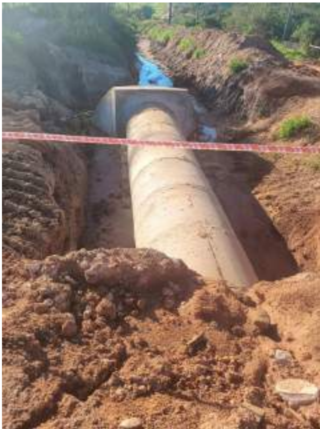
Fotografía N° 8: Colocación de alcantarilla tubular de hormigón armado.
