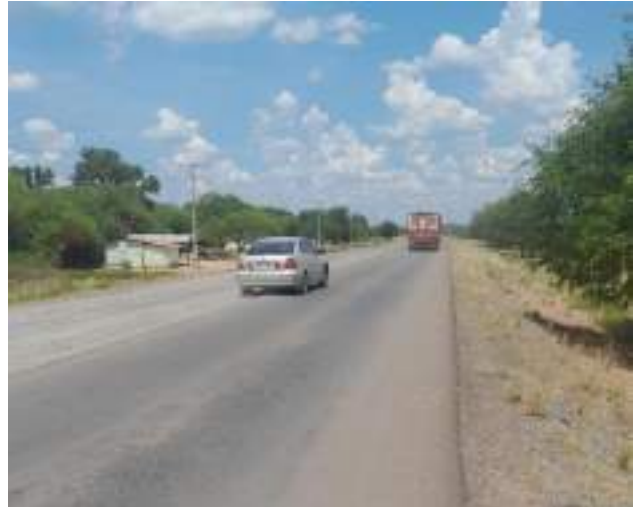
Fotografía 6: Otra vista del estado actual de parte del tramo
