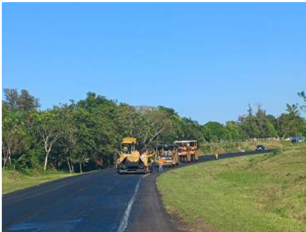
Fotografía N° 21: Trabajo de riego de liga en ejecución, en espera del asfalto para continuar con el recapado, en el distrito de Santa Rosa de Mbutuy.
