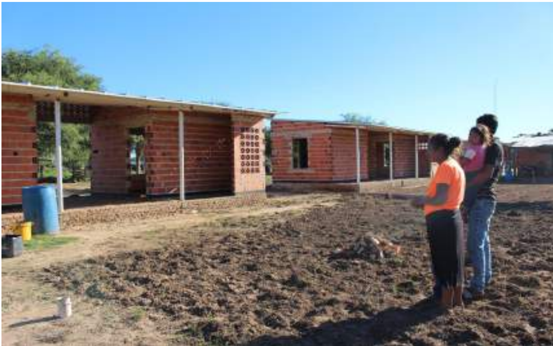
Fotografía N° 2: Viviendas en construcción. Familia beneficiaria.
