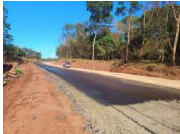
Fotografía N° 7: Base imprimada de una sola calzada.
