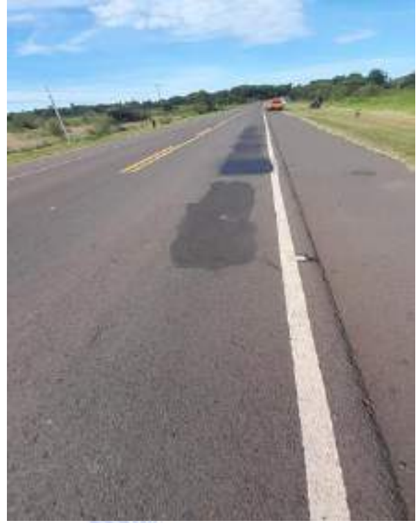
Fotografía N° 7: Bacheo en zona del Tramo 1 – Nueva Germania - San Pedro del Ycuamandiyu
