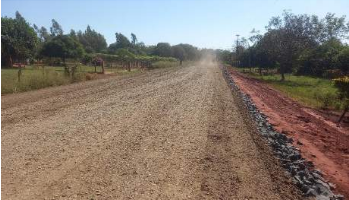
Fotografía N° 5: Tramo con base granular compactada.
