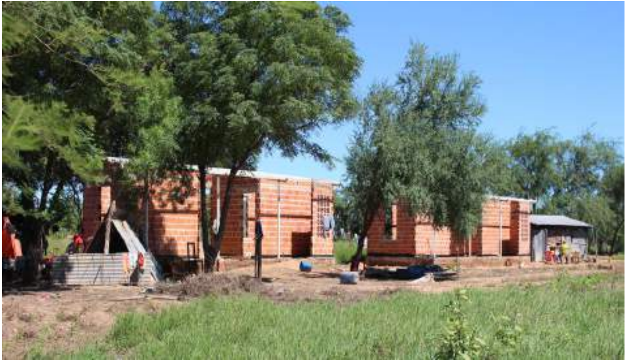
Fotografía N° 3: Viviendas en construcción al nivel de la altura con vigas y tirantes colocados.
