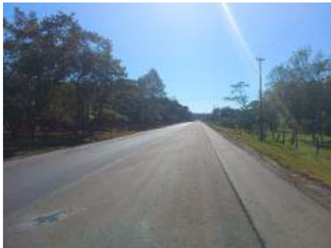
Fotografía N° 9: Visualización de la capa asfáltica
